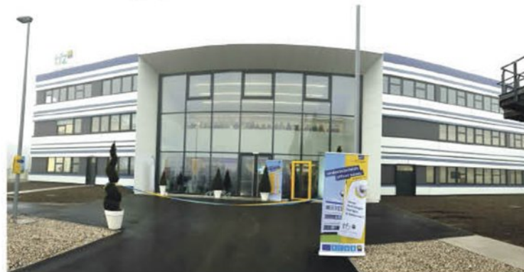
Der einjährige Bau des neuen Forschungs- und Technologiezentrums in Seibersdorf kostete insgesamt 17 Millionen Euro. Foto: Markus Leshem
